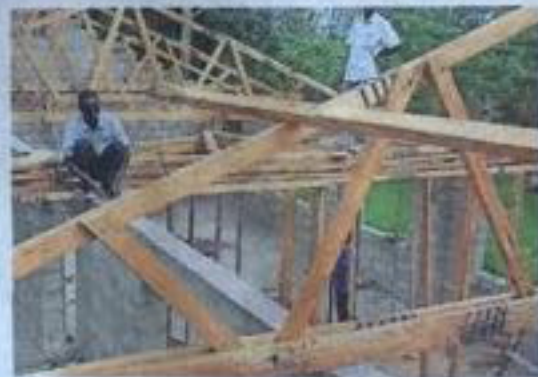
Der Bau der Klassenräume geht gut voran.
